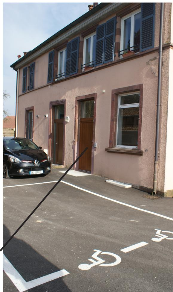
L'accessibilité PMR a été positionnée à l'arrière du bâtiment avec la création d'une place de stationnement et d'une porte secondaire d'accès (au lieu et place d'une fenêtre). Il a été installé un dispositif d'interphonie pour signaler une présence ; l'accueil de l'utilisateur a lieu dans la salle du conseil municipal.
